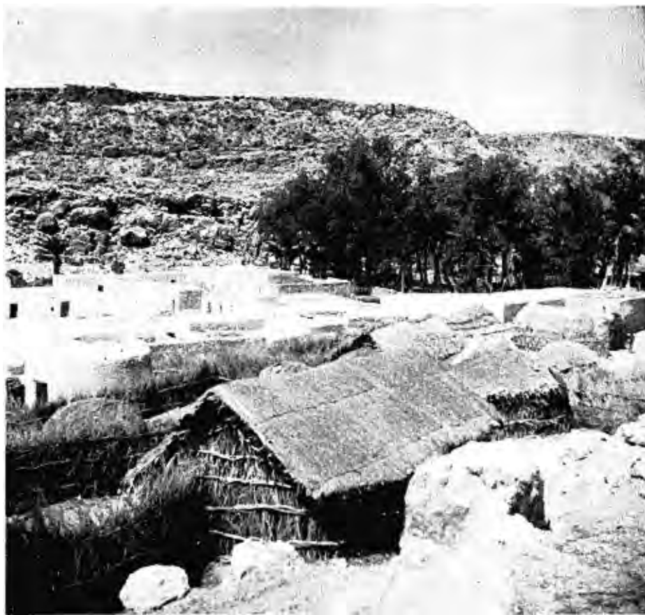
FIG. 1. — Eil, in Migurtinia - Sono visibili i vari tipi di abitazioni: in muratura alcune; in tronchi e frascato altre, vuoi a pianta rettangolare ( arisc ) che circolare ( mundul ); altre, infine, emisferiche, mobili ( akhal ).
